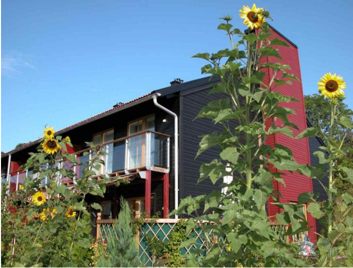
Bild: En tydlig kravformulering är grunden för att nå en lufttät byggnad. Lindåshusen är ett sådant projekt där kraven formulerades och följdes upp.
