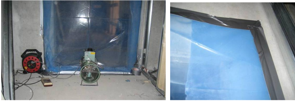
Figur 2 Fläkt och manometer monterade i dörr mot trapphus, tätning kring dörr.
