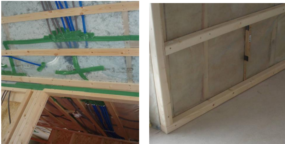
Bild: Genomföringar i tätskiktet kan undvikas om man använder indraget lufttätande skikt så att en installationsspalt bildas. Foton: Owe Svensson
