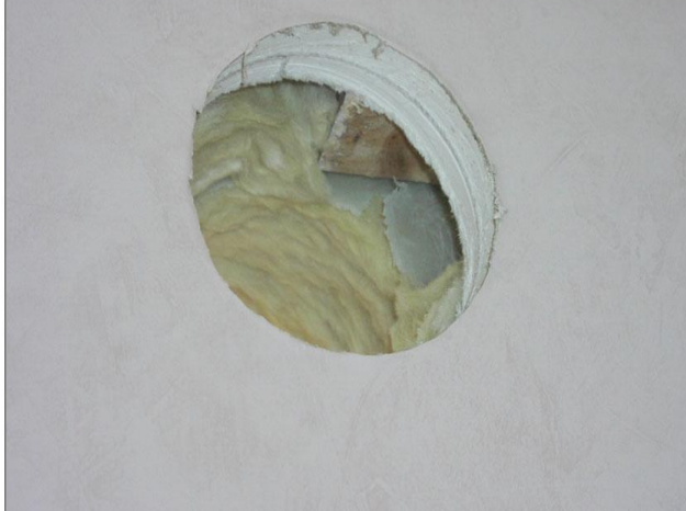
Bild: En håltagning i en befintlig konstruktion kan vara svår att få lufttät utan god planering. Foto: Eva Sikander
