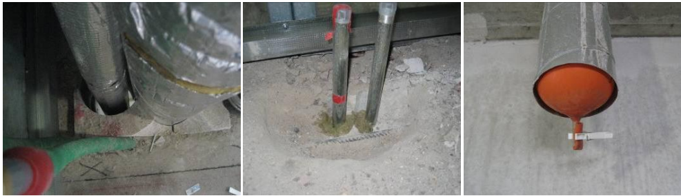
Figur 1 Hål kring genomföring i bjälklag, tätning med mineralull kring rör samt ventilationsrör tätat med ballong.
